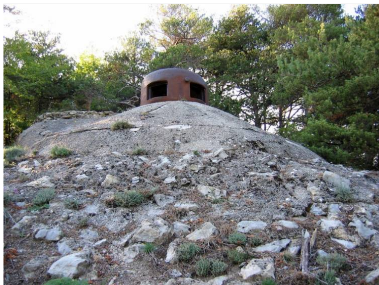
Bloc 3 surmonté de sa cloche observatoire. (cliché © Serge Forneris)
