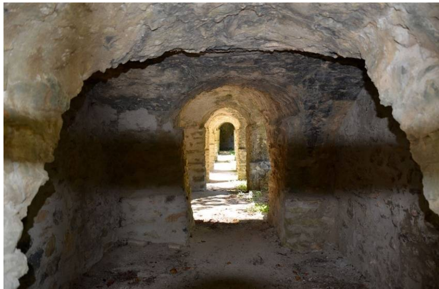
Galerie de voûtes de soutènement de la terrasse de la chapelle. (cliché © Patricia Balandier)
